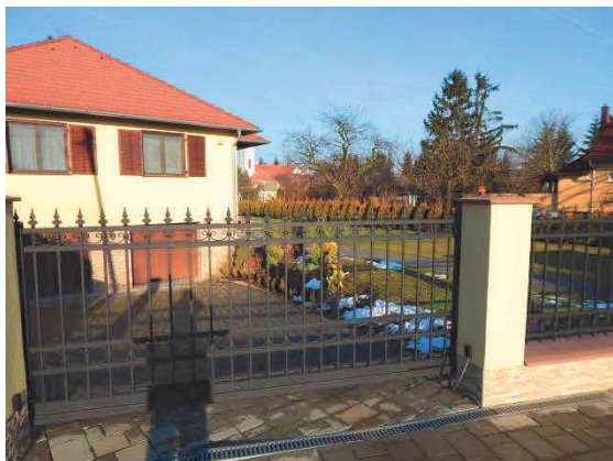
vasrácsos kerítés az épülettel azonos lábazattal, és a homlokzattal azonos oszlopokkal
